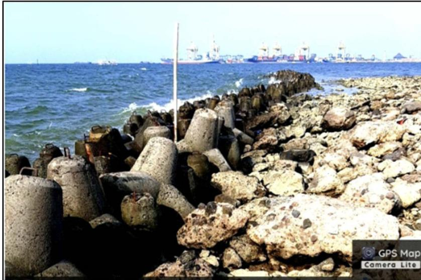
Gambar 5. Tetrapod beton untuk melindungi daratan agar tidak mengalami erosi oleh gelombang laut di pantai Kelurahan Bandarharjo, Kecamatan Semarang Utara, latar belakang adalah Pelabuhan Tanjung Emas
