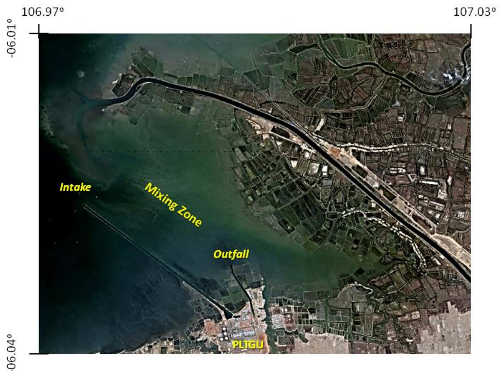
Gambar 1. Lokasi PLTGU dan Mixing Zone di Muara Tawar (sumber: Google Earth 2010)
